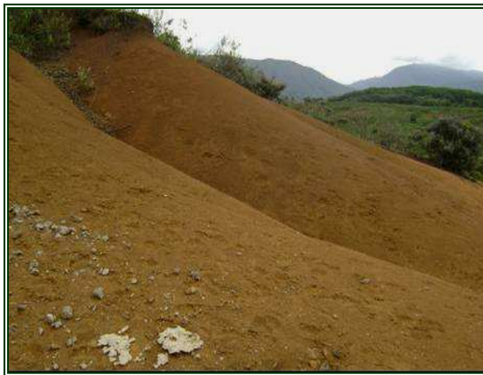
Fig. 9. Procesos erosivos localizados
