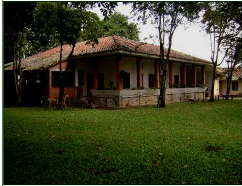
Fig. 7. Centro habitacional casa colonial
