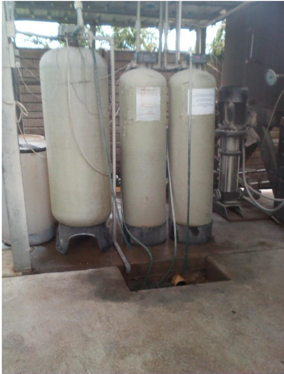
FIGURA N°6- TANQUES DE AGUA SUAVIZADA
