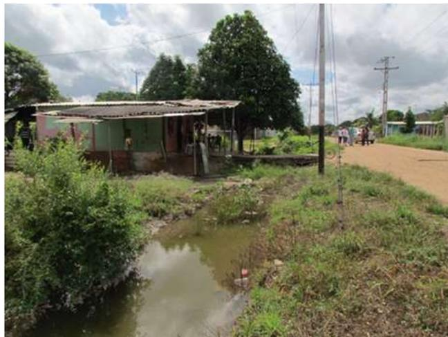
*Foto 9.* Canales de desagüe sin mantenimiento y se desbordan cuando llueve.
