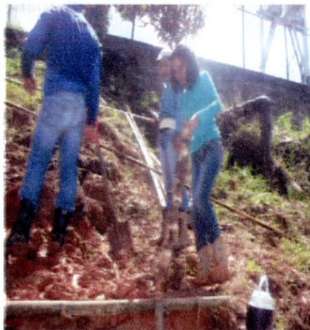
Figura 10. Construcción de terrazas con el uso de enfajinado.
