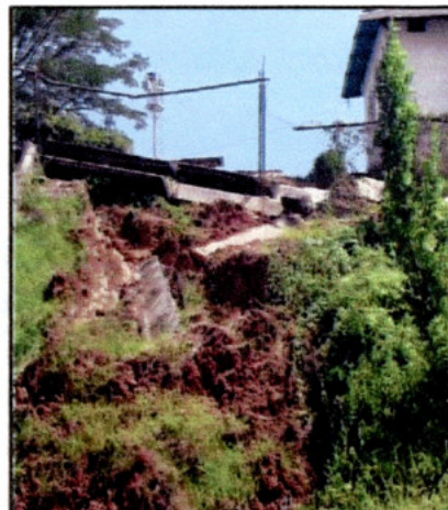
Figura 8 Talud frontal (lluviosa)
