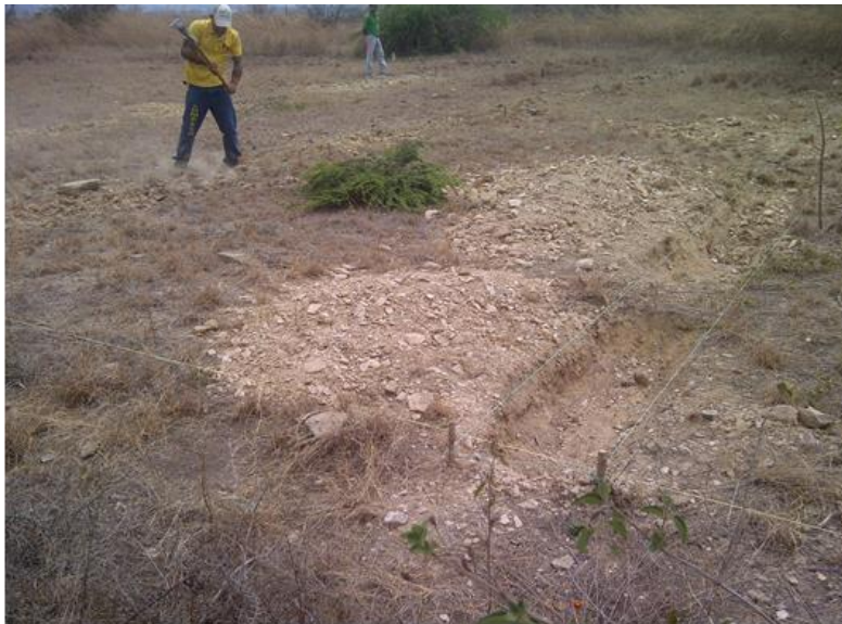
Figura 2. Construcción de los canales de infiltración del área en estudio.
