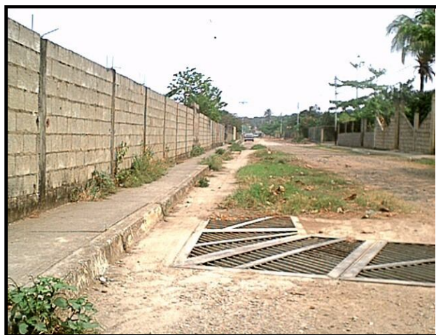
Foto: Canal embaulado y rejilla metálica. Tramo 8.
