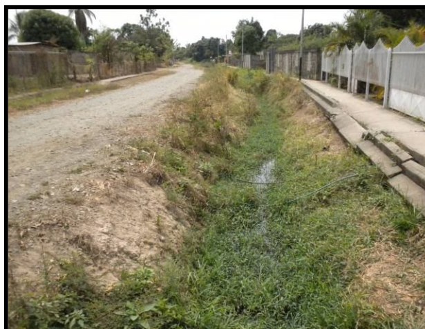
Fotos: Canal de tierra. Sección trapezoidal. Tramo 12 y 13. En mal estado
