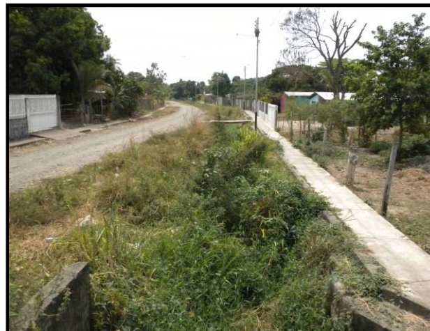
Foto: Canal de tierra. Sección trapezoidal. Tramo 12. En mal estado
