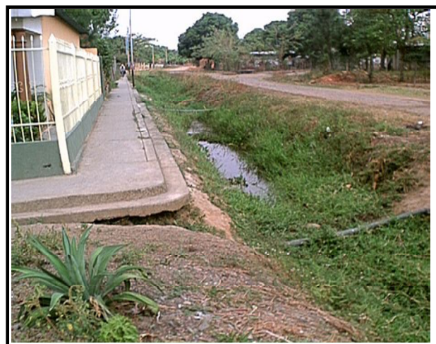
Fotos: Canal de tierra. Sección trapezoidal. Tramo 12 y 13. En mal estado
