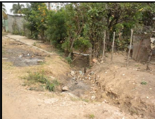
Foto: Drenaje de la calle hacia terrenos de viviendas (drenaje natural modificado).
