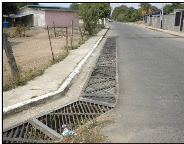
Foto: Rejillas en calle, para la esorrentía.
