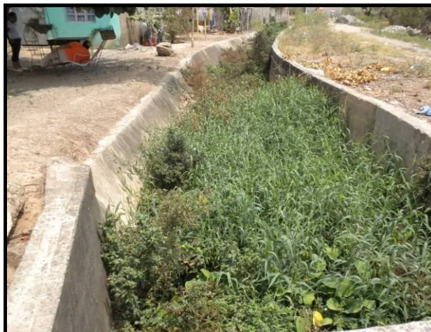
Foto: Canal revestido de concreto armado. Sección mixta tramo 11.
