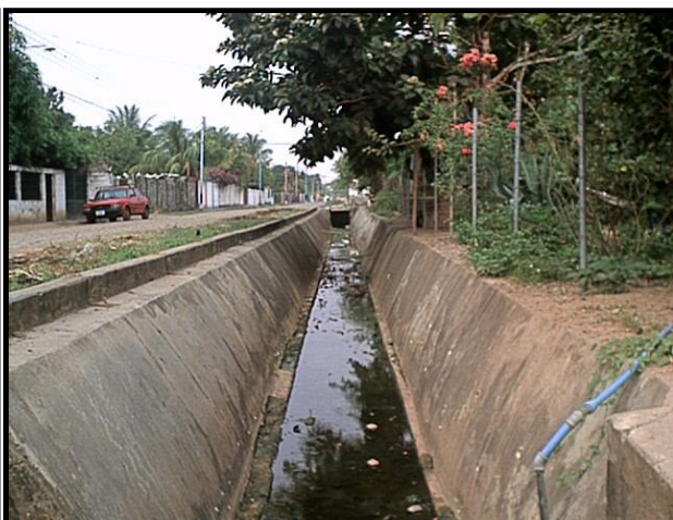
Foto: Canal revestido de concreto de forma trapezoidal. Tramo 9.
