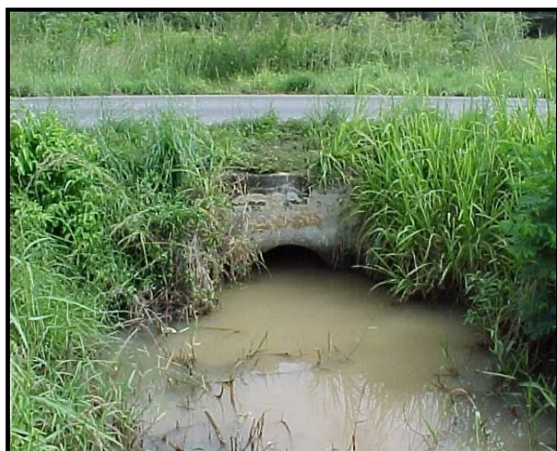
Foto: Estructura de drenaje de la vialidad Guanare–Biscucuy (alcantarilla). Punto de salida de la microcuenca.
