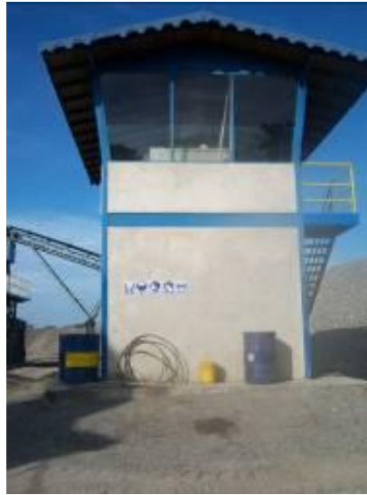
Figura 57. Caseta de mandos, de la planta procesadora.
