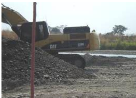
Figura 3. Utilización de balizas, para la delimitación del área de extracción
