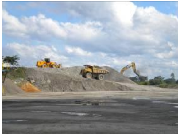
Figura 7. Sector destinado para el acopio del granzón natural
