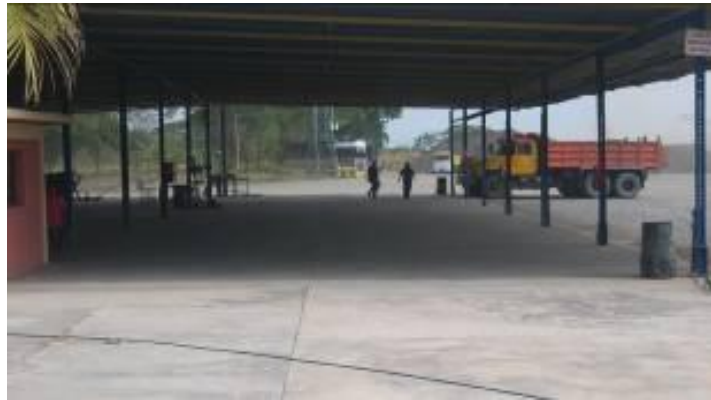
Figura 22. Vista del galpón destinado para el mantenimiento de maquinaria y vehículos.
