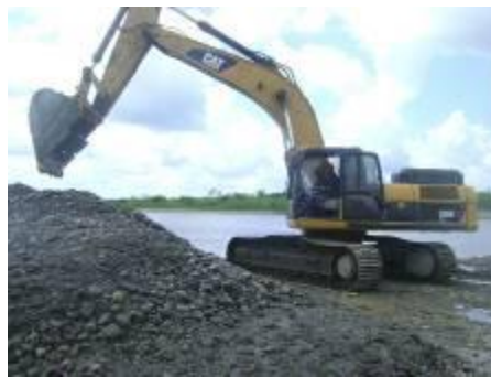
Figura 4. Maquinaria empleada en la actividad de extracción. Excavador
